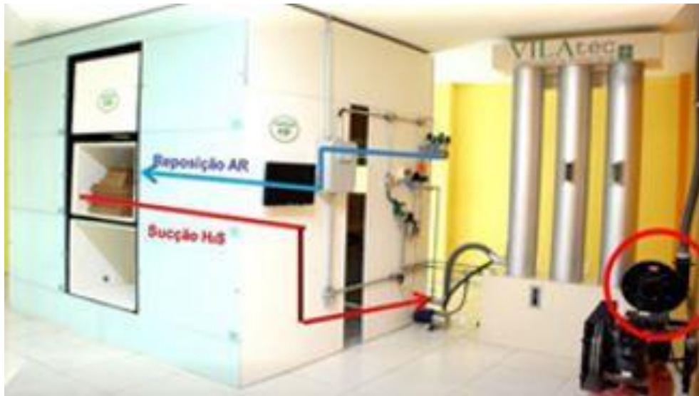
Figura 6 – Troca gasosa da Estação de tratamento de Efluentes de Necrópoles
